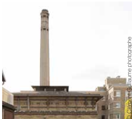
cheminée de la Chaufferie 1930-1934
